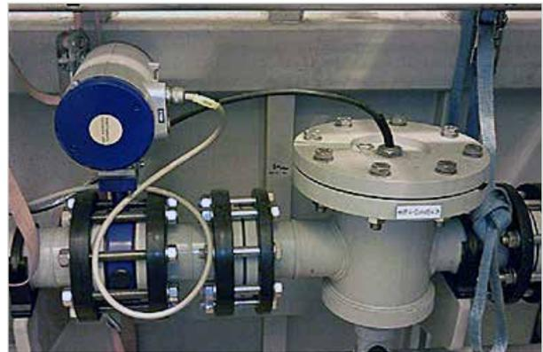
安装的声速传感器和电导率传感器
