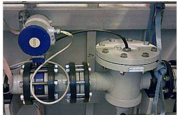
安装的声速传感器和电导率传感器
