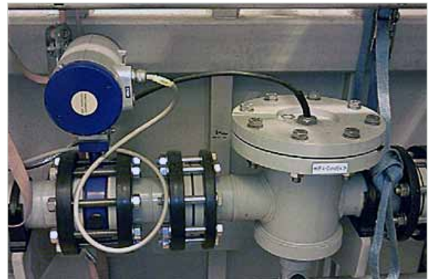
安装的声速传感器和电导率传感器
