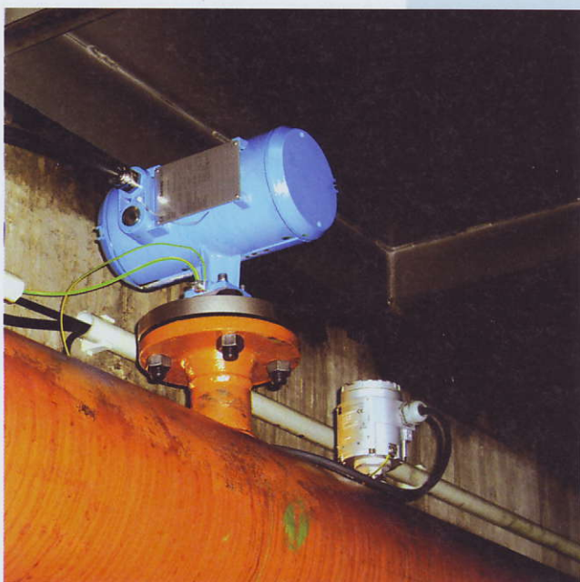
图2 安装在主供油线 的液态声波 传感器
