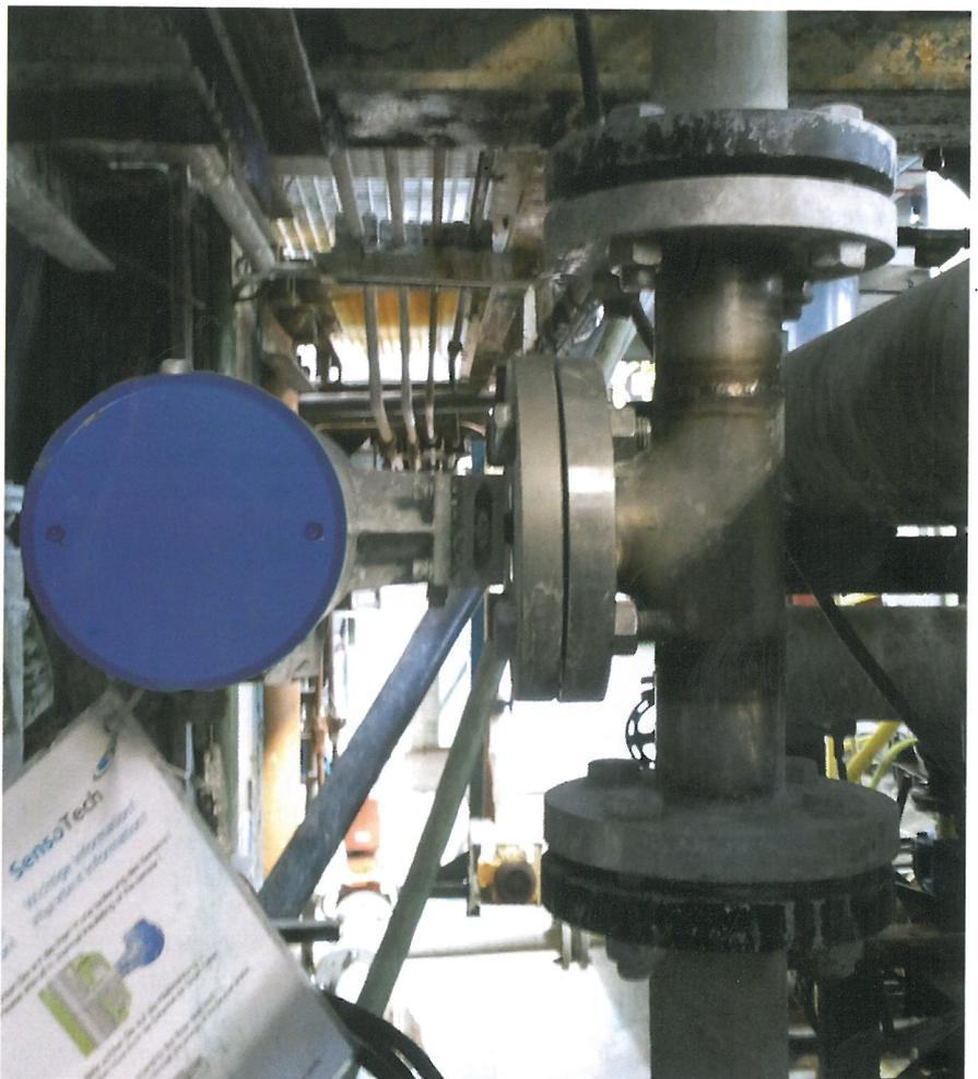
**Bild 3: Eingebauter Tauchsensoren in der Beisanlage der AMAG Austria Metall AG**
