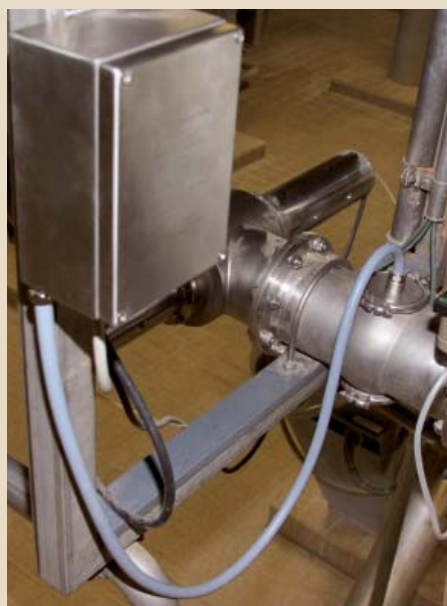
Abb. 1 Messstelle am Läuterbottich der Warsteiner Brauerei
